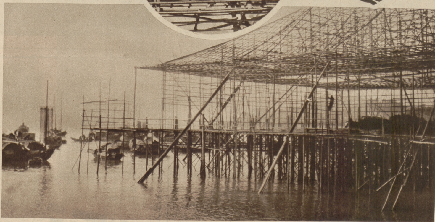
Das Skelett der Bambushalle für die 800 Hochzeitsgäste.
