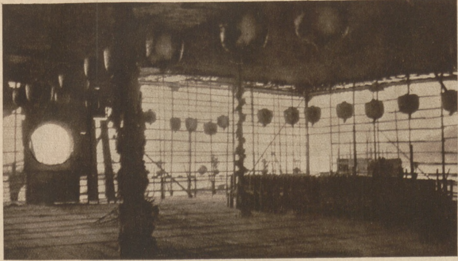
Innenansicht der fertigen Halle.
