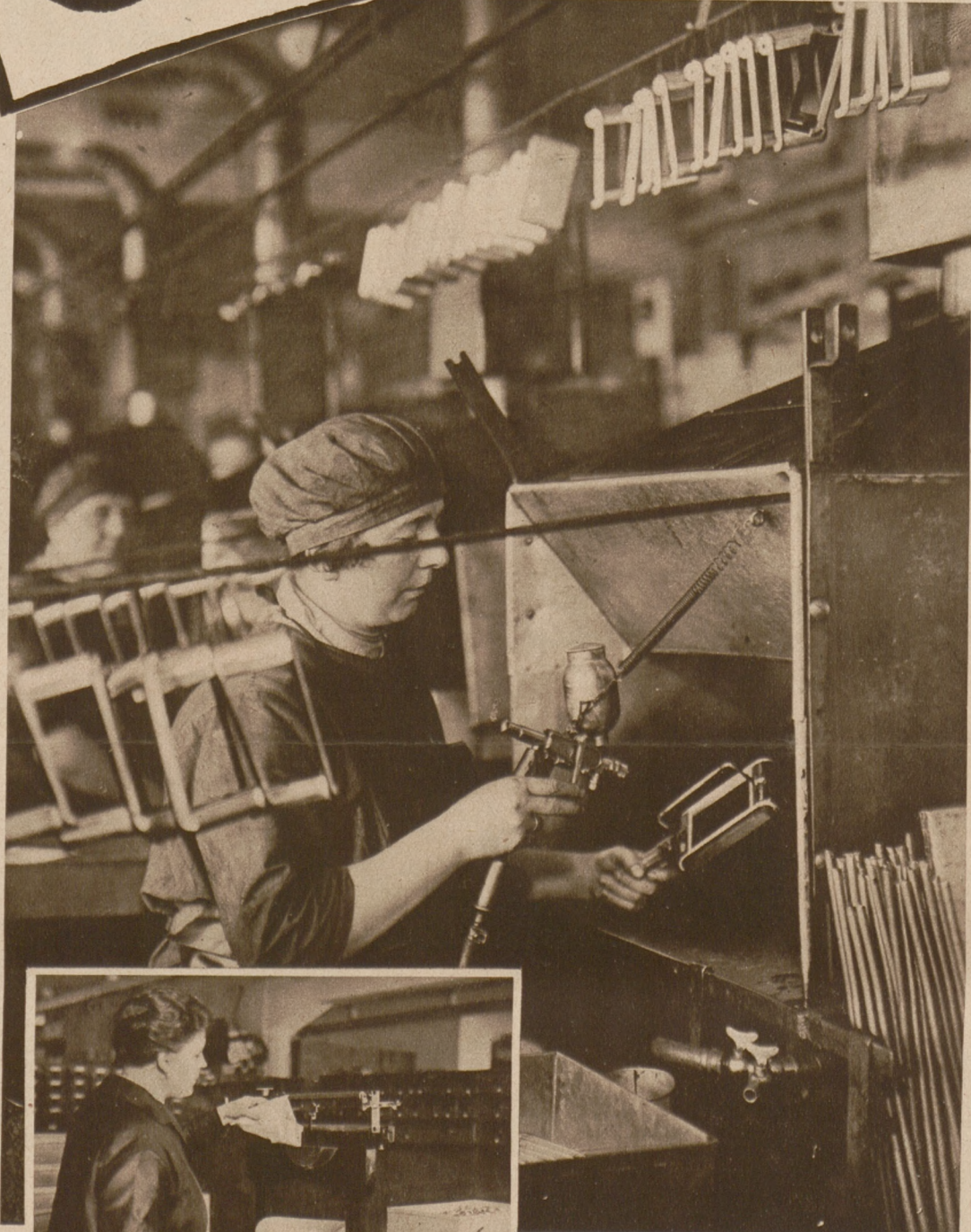
Ganz wie in der Automobil-Fabrik. Das laufende Band gleitet von Arbeitsplatz zu Arbeitsplatz. Jeder vollführt nur einen Handgriff. In 50 Minuten ist eine Agfa-Kamera zusammengeleht.
