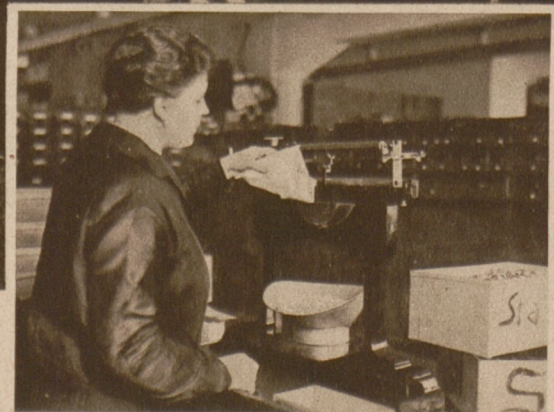
Die Waage als Rechenmaschine. Für die Seilenarbeit werden die dazu nötigen kleinen Einzelteile abgewogen statt abgezählt. Das Gewicht gibt die genaue Stückzahl an.
