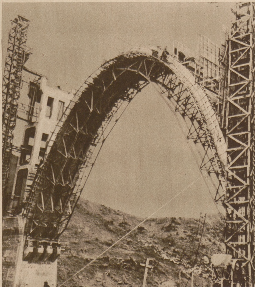
Ein riesiger Brückenbogen wird gegossen.
