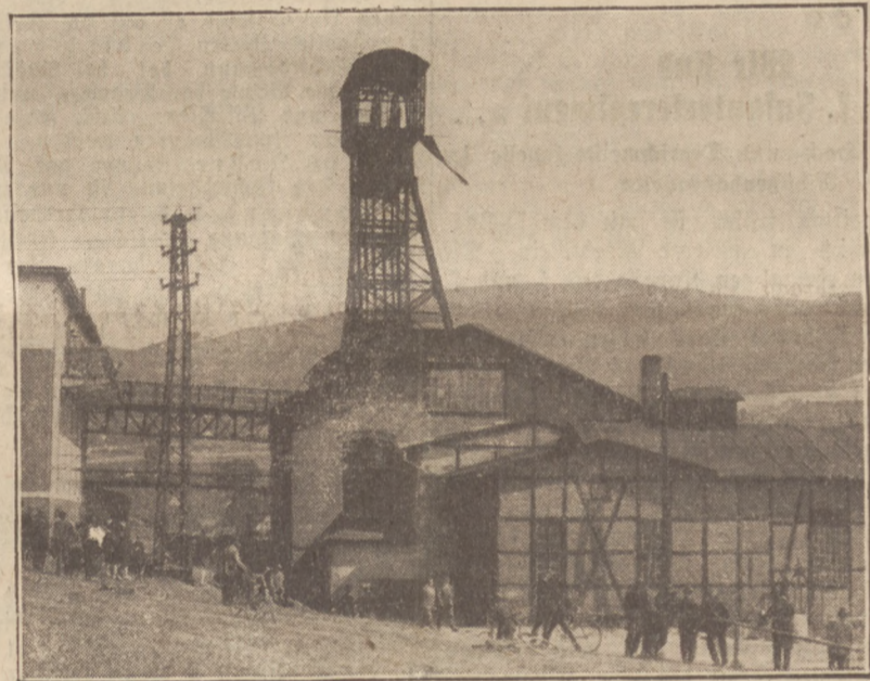
Schachtanlage der Unglücksgrube, in dessen Bereich der Kohlenäureinbruch erfolgt ist
