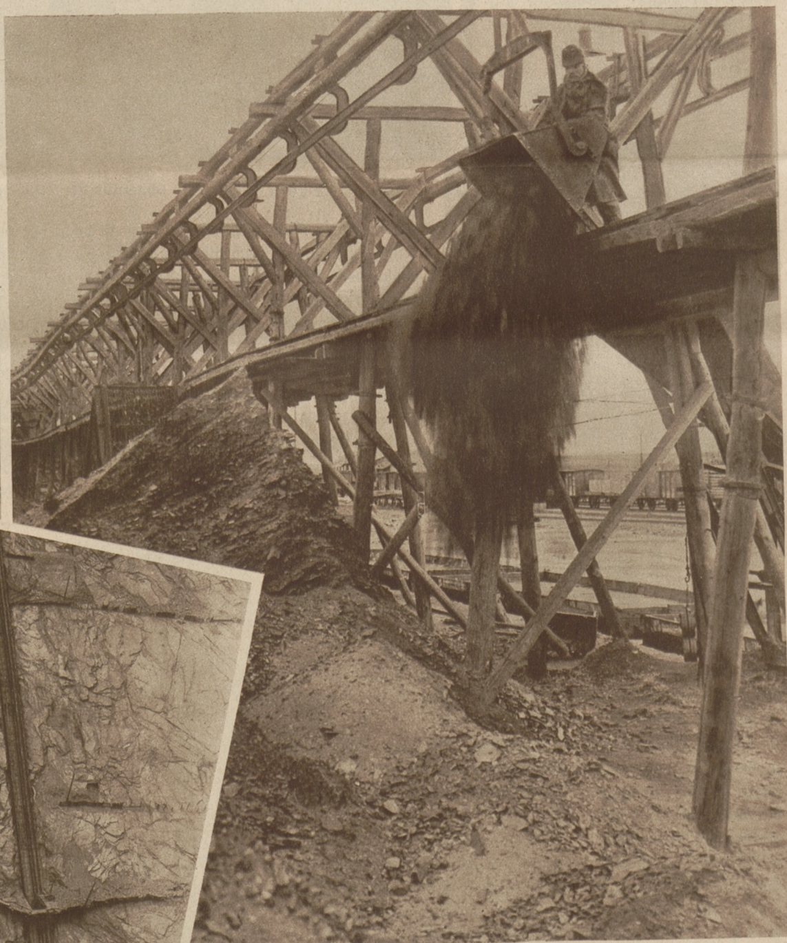
Immer neue und neue Hängeloren kommen mit der Drahtseilbahn an, werden gekippt — und weiter wandern die Erze in die Schmelzöfen.
