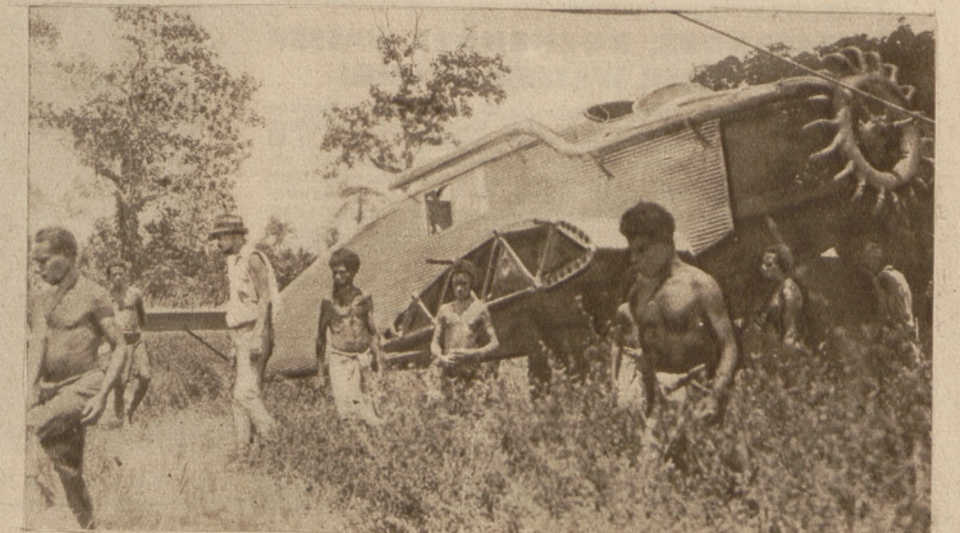
Montage einer Junker-F-18 im australischen Urwald.
