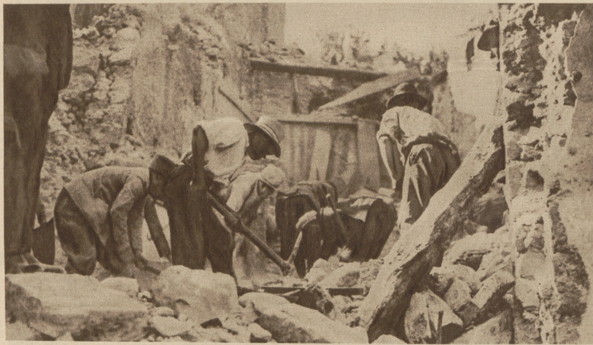
Bergungsarbeit im Trümmerfeld.
