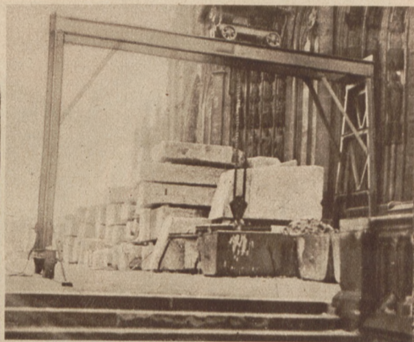
Eine „Sendung“ Muschelkalk-Steinblöcke aus Franken, die zur Erneuerung der verwitterten Sand- steine mit ihrer zerbrochenen Pracht dienen.
