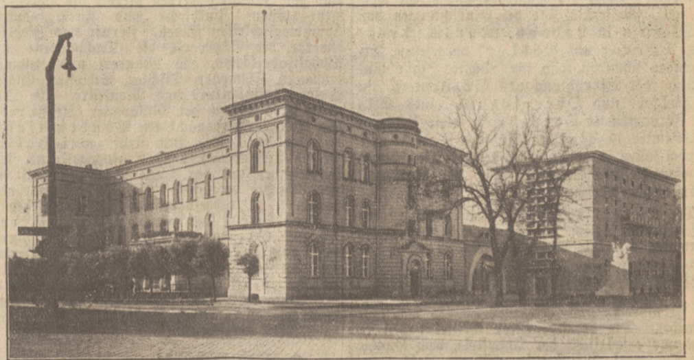
Verwaltungsgebäude der Oberpostdirektion Oppeln
