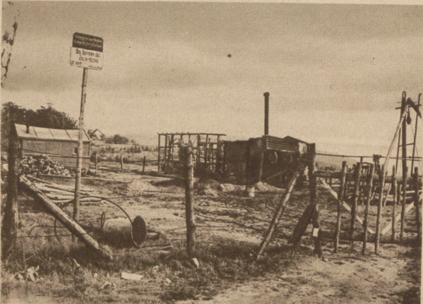
Blick auf die Tagesanlagen.
