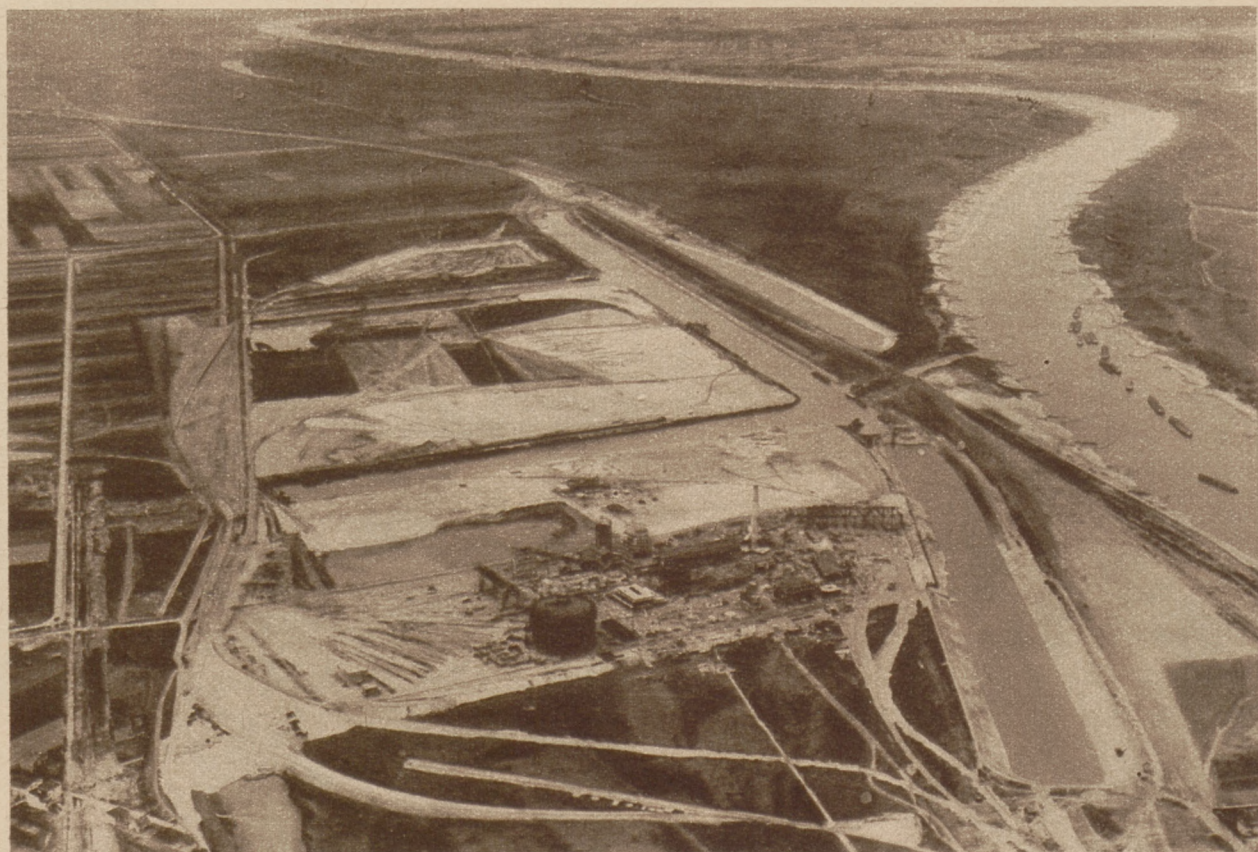
Magdeburg bekommt durch den Bau des Mittellandkanals einen neuen Hafen. Rechts die Elbe, halbrechts daneben der nahezu fertiggestellte Zweigkanal. Dazwischen die Mündungstrecke des Elbabstiegs vom Mittellandkanal; hinter den Industriegebäuden die neuen Industrieböden.
