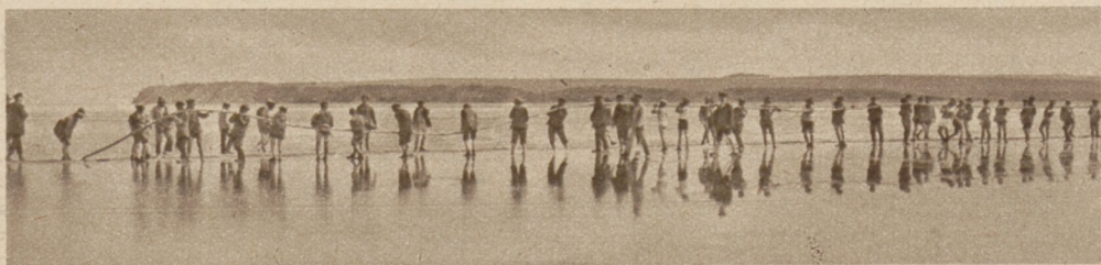
Aus Schleppen eines Seekabels über eine Untiefe.
