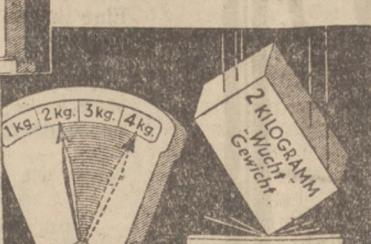
Nun lassen Sie denselben Gegenstand plötzlich auf die Waage fallen. Augenblicklich wird die Wäge bis zum doppelten Gewicht ausschlagen. Dies entspricht der Wucht der Stöße, die ein Lastwagen während der Beladung und Fahrt auszuhalten hat.
