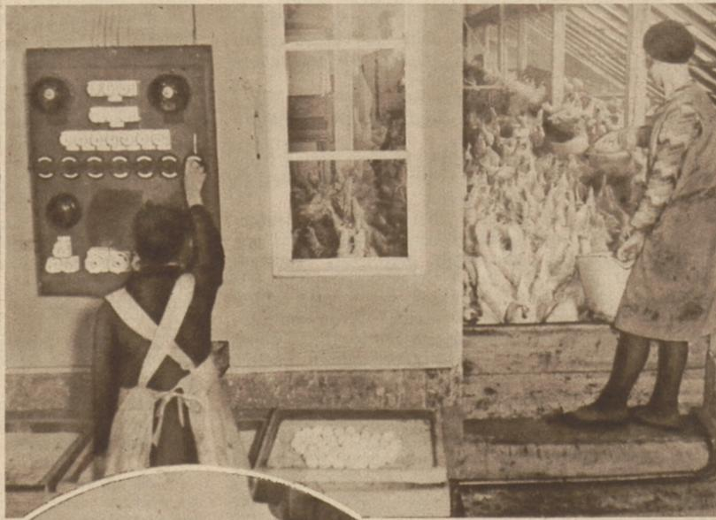
Die Schalttafel, mit deren Hilfe die laufenden Bänder in Betrieb gesetzt, die elektrische Heizung sowie das Licht eingeschaltet werden.
