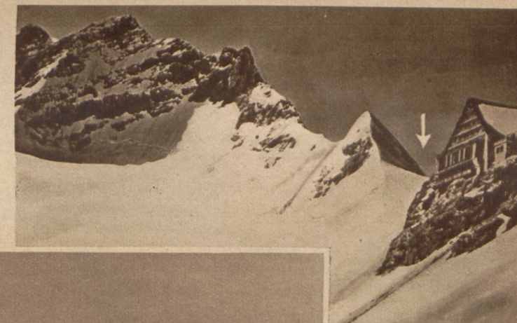
Das Berghaus der Station Jungfraujoch. Der Pfeil zeigt auf die Startstelle.
