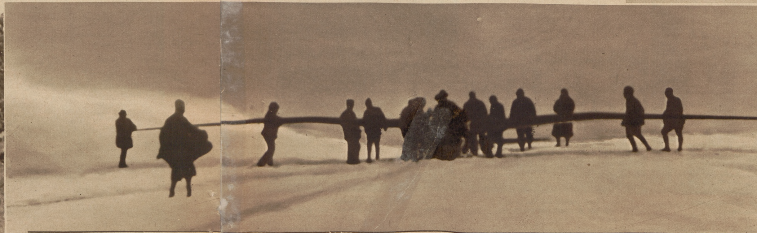
Das fertige Flugzeug — die Haltemannschaft vorn — im Hintergrunde des Bildes die Startmannschaft mit dem Summenseil.
