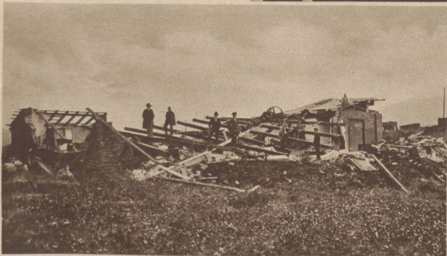
Vollständig vernichtetes Fabrikgebäude in Plettenberg-Oberstadt.
