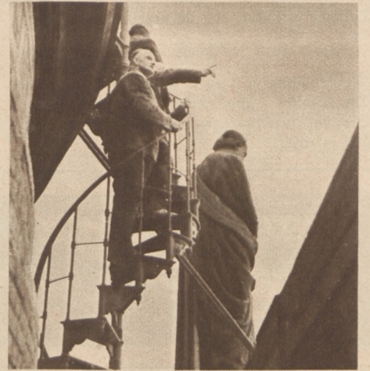
Die Treppe zwischen Himmel und Erde befindet sich zwischen dem Dach und der Kuppel des Berliner Schlosses.
