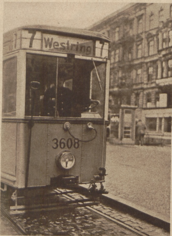
Die ersten Scheibenwischer bei der Straßenbahn. Auf der Berliner Straßenbahn sind jetzt zum ersten- mal Scheibenwischer an den Triebwagen angebracht worden, um die Verkehrssicherheit zu erhöhen.
