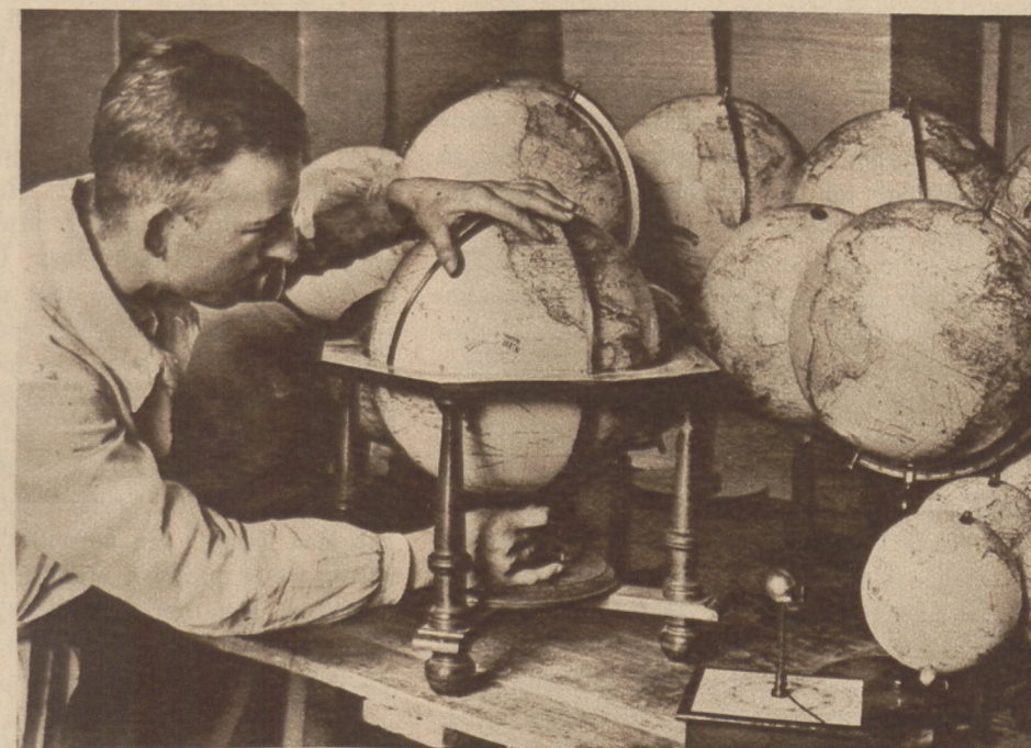
Die Neigung der Globen wird nachgeprüft.
