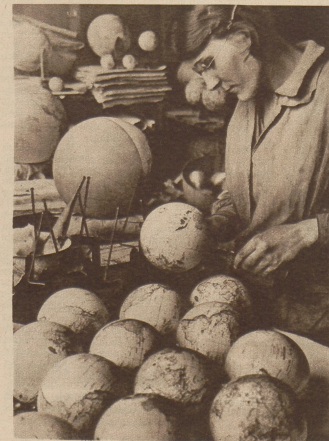
Die lanzettförmig bedruckten (um die Rundung zu erzielen) Kartenblätter werden ausgeschritten.
