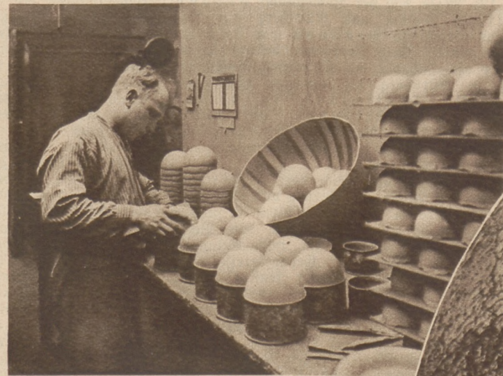
Aus Steinpappscheiben werden durch Pressen Halbkugeln hergestellt.
