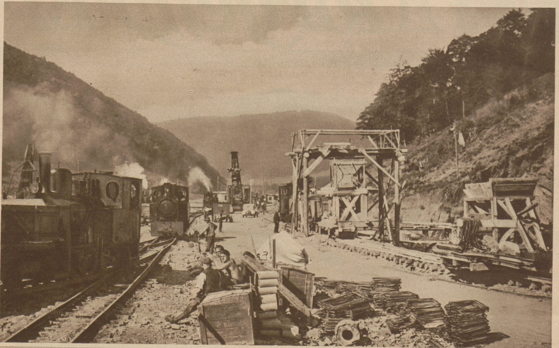
Vom Bau der Odertalsperre bei Bad Lauterberg (Harz). Eine öffentliche Straße geht noch mitten durch das Baufeld.
