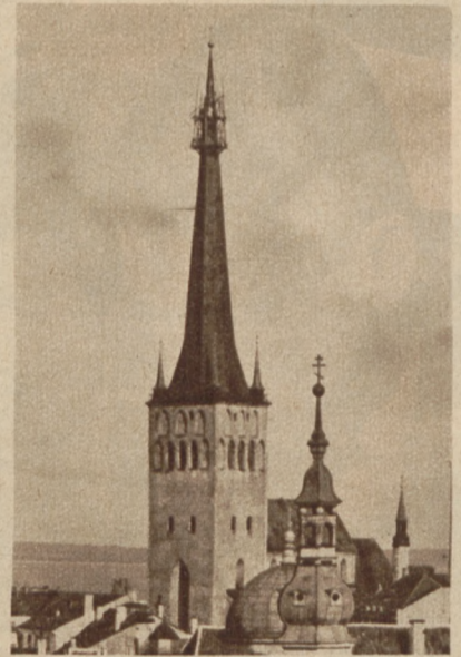
Der St. Olai-turm in Reval mit dem Baugerüst. Ein Blitzschlag hatte am 27. Juli d. J. die Turmspitze in Brand gesetzt.
