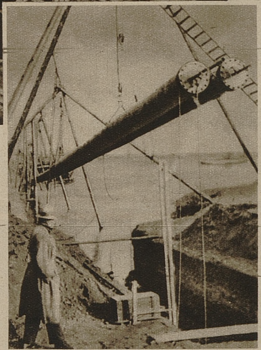
Eine Ferngasleitung wird in den Rhein versenkt.
