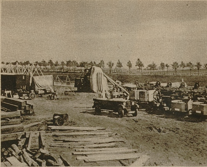
Maschinenpark zum Leitungsbau.
