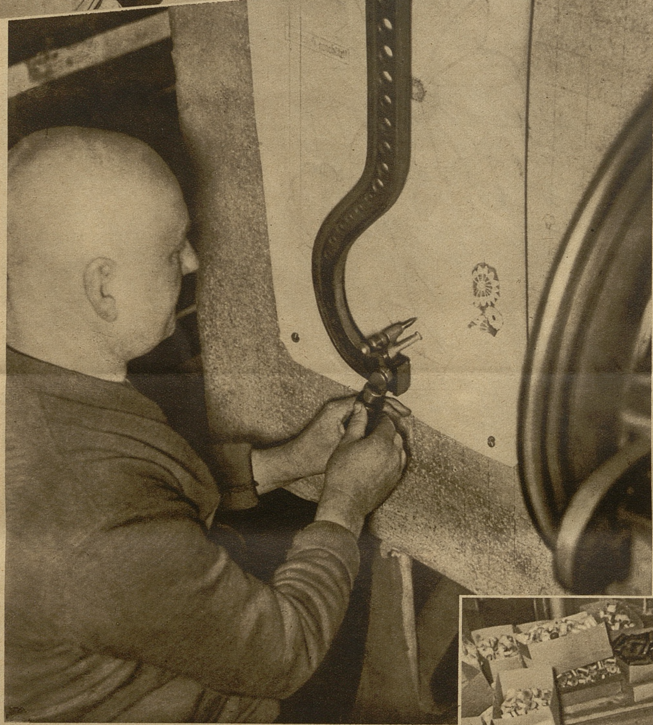
Der Sticker an seiner Maschine im Betrieb. Er muß sich genau an die auf der Schablone vorgezeichneten Stiche halten. Für diese Rosette sind etwa 9500 Stiche notwendig. Ein Sticker schafft in der Woche ungefähr 240 000 Stiche.
