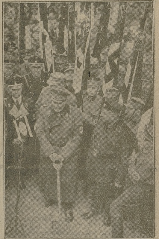
Arbeitsbeginn an der Autobahn Berlin - Stettin
