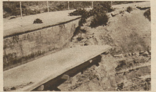
Im Kampf gegen die Zerstörung. Dieses Bild zeigt, wie das Oberland durch mancherlei Bauten gegen weiteren Abbruch geschützt wird, zeigt aber auch, wie trotzdem der Abbruch weiter fortschreitet. (In der Mitte, vor den Pflanzen, ist die Schutzmauer schon wieder infolge Unterhöhlung abgebrochen.)
