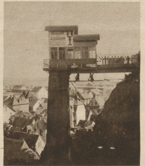
Kein Förderschacht, sondern der Aufstieg ins Oberland der Insel für die, die nicht die lange Treppe steigen mögen.
