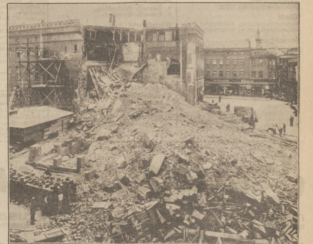
Der Einsturz des Oplerner Rathhausturmes
