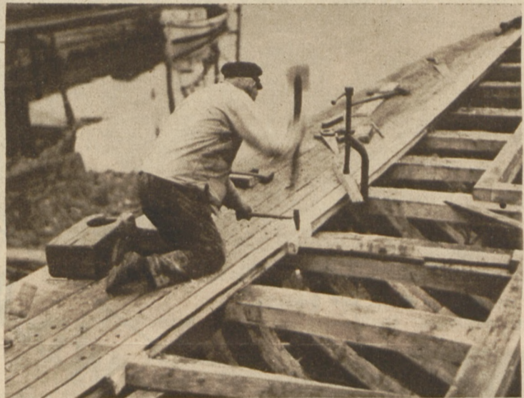
Eine Arbeit der Erfahrung und des Geschicks ist das Plankenlegen. Jede wird einzeln erst festgeteilt, nachdem sie vorher zurechtgeschnitten wurde, und dann mit den schweren Rägeln am Gebälk befestigt.
