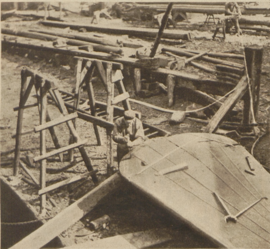
Ein echter Schiffszimmermeister arbeitet zumeist nach Augenmaß. Beschneiden eines Schwertes.
