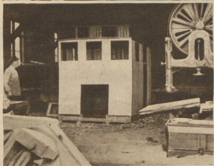
Auf dem Kutter wird noch Deckarbeit gemacht, aber in der Fischerei steht das Ruderhaus schon fertig da.
