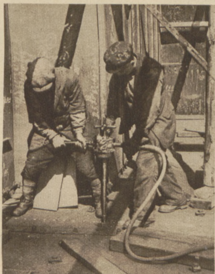
Beim Bohren der unzähligen Nietlöcher.
