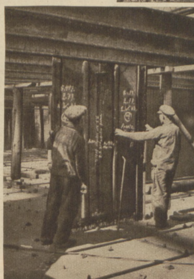
Eine Kabinenwand wird aufgestellt.
