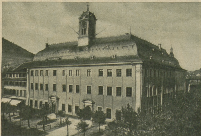
Als Ausdruck des Dankes der vielen Amerikaner, die auf deutschen Hochschulen ihre wissenschaftliche Bildung erwarben, wurde in den Vereinigten Staaten eine Sammlung zum Neubau der Universität Heidelberg veranstaltet. Bereits die Hälfte der Baukosten ist sichergestellt; die amerikanische Steuergesellschaft hat es übernommen, den Rest der Bauumme aufzubringen S. B. D.
