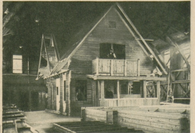
Ein Holzhausbau in der Halle. — Die Probeaufstellung
