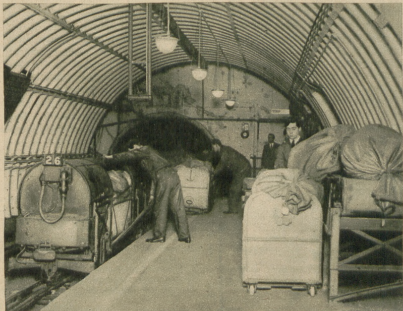
In London sind zur schnellsten Abwicklung des Postverkehrs die Hauptpostämter miteinander durch kleine Untergrundbahnen verbunden, in denen elektrisch betriebene Züge ohne Begleitung verkehren. Ankunft eines solchen Zuges auf der Untergrund-Station eines Postamtes
