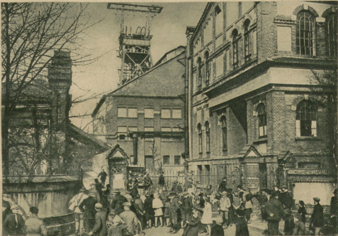
Eingang zur Grube „Ewald“ bei Redlinghausen, auf der sich das schwere Unglück ereignete. Infolge Versagens des Teufelsteigers (Zielfenstiegers) der Fördermaschine wurde bei der Seilschleife zum Schichtwechsel der eine Förderkorb unter die Seilscheibe gedrückt, während der andere Korb in den Schachtlumpf gestaut wurde. 12 Tote und 35 Verletzte sind zu beklagen. Kevfi
