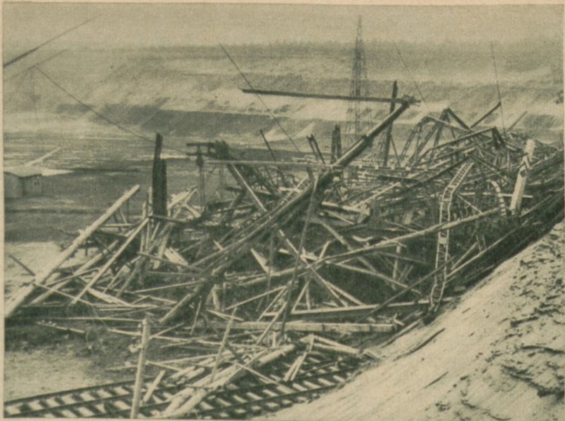
Die Unglücksstätte in Lauchhammer (Niederlausitz), wo ein gewaltiger Wirbelsturm eine große auf der Orube „Friedländer“ im Bau befindliche Abraumförderbrücke mit ihrem Montagegerüst plötzlich zum Einsturz brachte. Zwölf Arbeiter kamen dabei ums Leben, mehrere andere wurden schwer verletzt. Fotoaktuell
