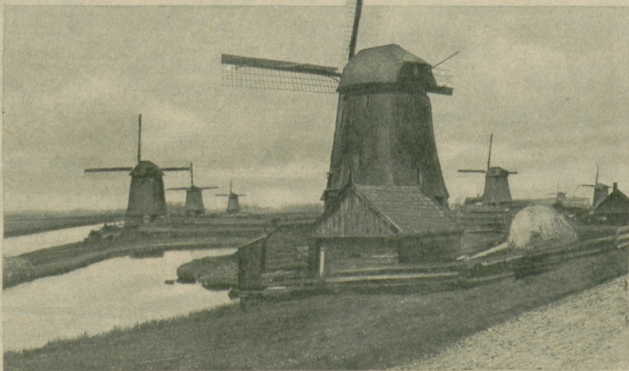
Windmühlen in Nordholland. Sie heben mittels archimedischer Schrauben das Wasser aus den Poldern in die Kanäle Eigene Aufnahmen des Verfassers
