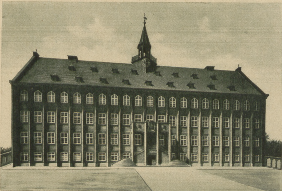
Ein schöner neuzeitlicher Backsteinbau ist das neue Gebäude des Gymnasiums zu Gütersloh, das vor kurzem unter starker Beteiligung aller Schüler eingeweiht wurde. Die Grundsteinlegung erfolgte vor zwei Jahren bei der Feier des 75-jährigen Bestehens dieser stiftischen Anstalt, an der seinerzeit Friedrich Wilhelm IV. und Wilhelm I. besonderes Interesse nahmen.
