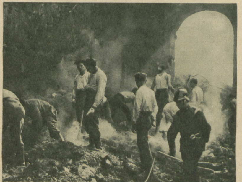
Dem großen Theaterbrand in Madrid fielen mehrere hundert Menschenleben zum Opfer. Das Theater sowie die benachbarten Gebäude sind völlig zerstört. — Feuerwehr und Militär beim Aufräumen der Trümmer Keystone
