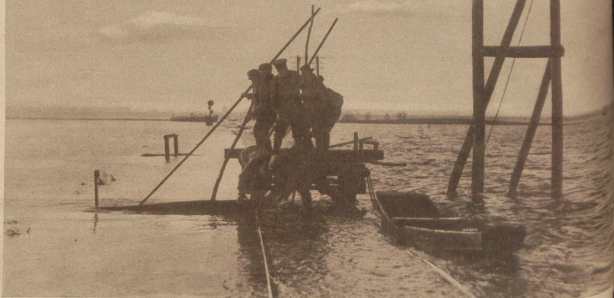
Das Land stand meilenweit unter Wasser, Brücken und Telephonmaste waren weggeschwemmt, der Fernverkehr unterbrochen. Viel Vieh kam in den Ställen der unter Wasser stehenden Ortschaften um. — An der Bahnstrecke Liegnitz-Küstern versuchen Arbeitskolonnen das angeschwemmte Holz aufzufischen
