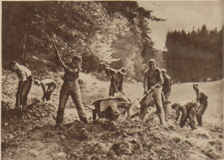
In Deutschland ist in diesem Sommer mit den in verschiedenen Gegenden erstmalig errichteten Arbeitslagern der praktische Versuch eines freiwilligen Arbeitsdienstes durchgeführt worden. — Tübinger Studenten sind bei Munzingen mit Chauffierungsarbeiten eines Waldweges beschäftigt
