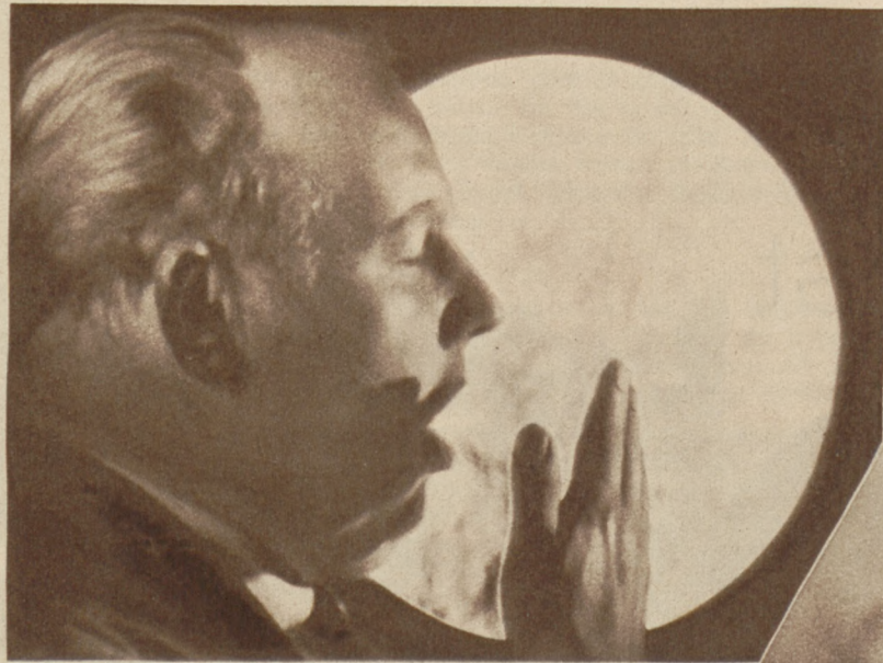
Sichtbarmachung der ausgeatmeten Kohlen säure und der ausstrahlenden Wärme eines Menschen durch den Schlierenapparat
