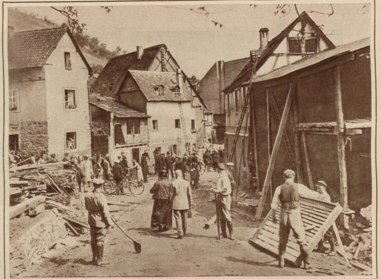
Während der Aufräumarbeiten in den Straßen von Gölz
