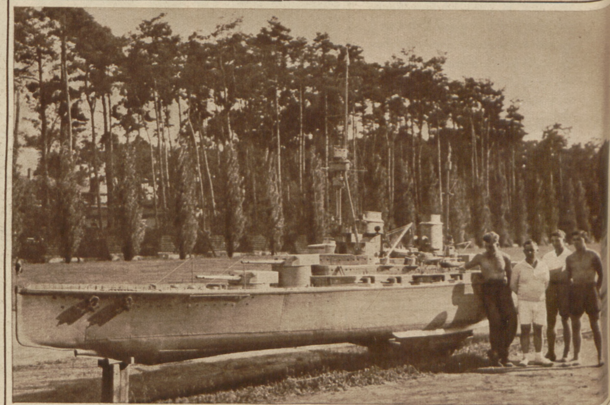
Bild unten: In der Potsdamer Modellbauerschule, von der wir kürzlich berichteten, ist nach 27-jähriger Bauzeit ein Modell des Schlachtkreuzers „Göbenburg“ im Maßstab 1:20 fertiggestellt worden, das eine Geschwindigkeit von 12 Kilometer in der Stunde erreicht und zu einer Fahrt von Potsdam nach Hamburg geeignet ist
