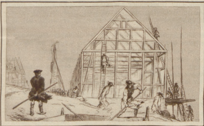
Bei den Aufbauarbeiten
