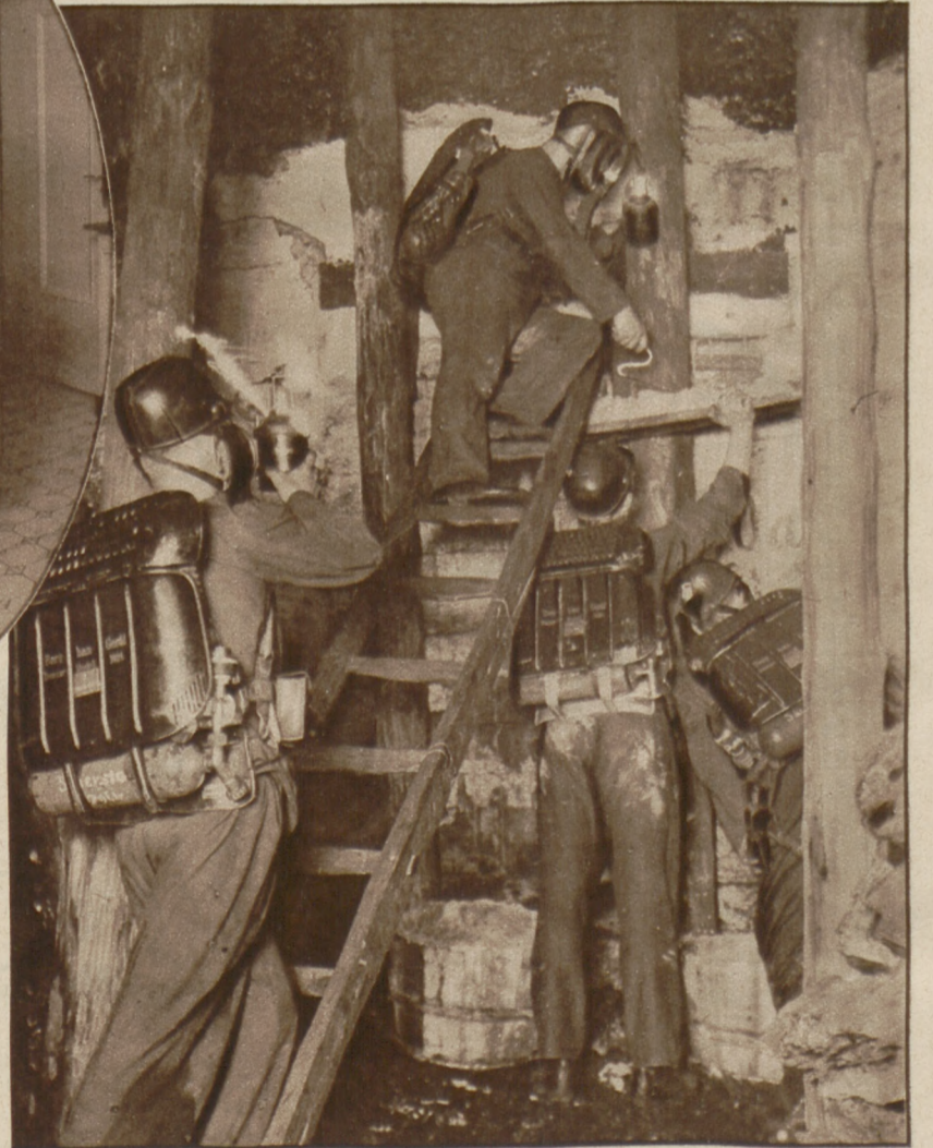
Unten: Gefahr der Gegenwart: Die Bergleute sind häufig von Gasgefahr bedroht. — Bergarbeiter mit Gasmaske und Sauerstoffapparaten bei Versteigungsarbeiten im Stollen
