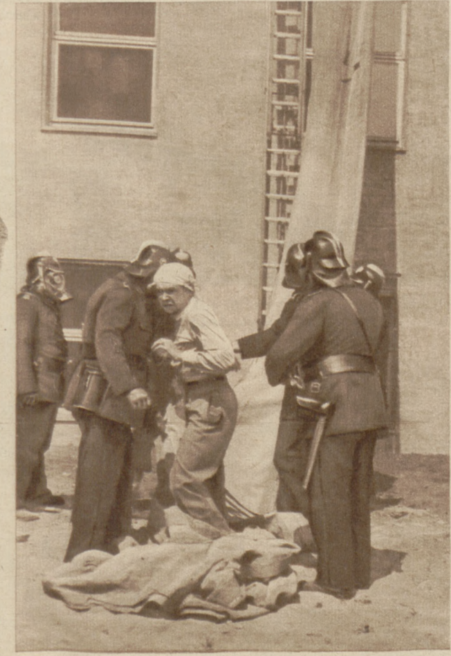
Nach dem Fliegerangriff: Feuerwehr bei der Rettung von Hausbewohnern durch große Schläuche
