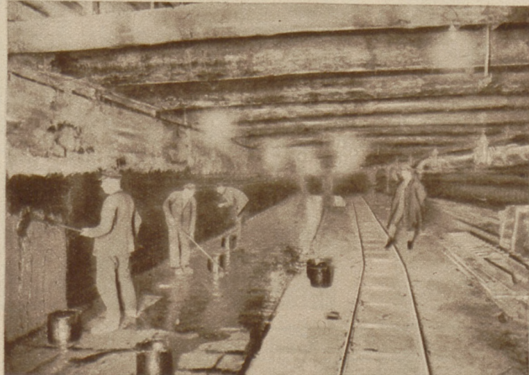
Die Wände des endlosen Schlauches der Untergrundbahn müssen gegen Grundwasser sorgfältig abgedichtet werden
