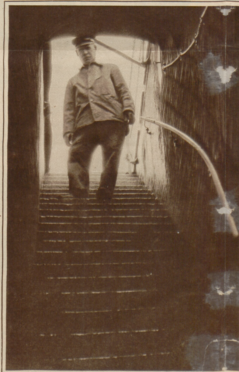
Abstieg in die Unterwelt zur Kanalisationsanlage
