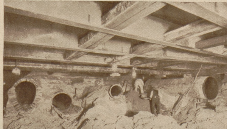
Die Arterien des unterirdischen Reiches werden beim Bau der Untergrundbahn im Querschnitt freigelegt
