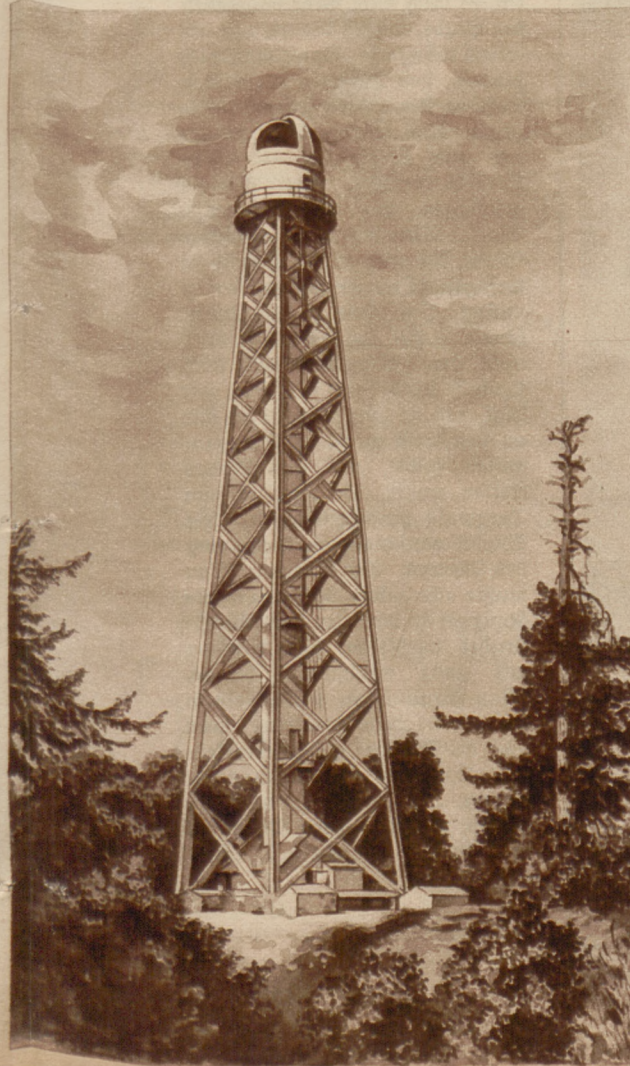
Vorn: Turmteleskop der Mount-Wilson-Forschungsstätte mit unterirdischem Arbeitsraum
