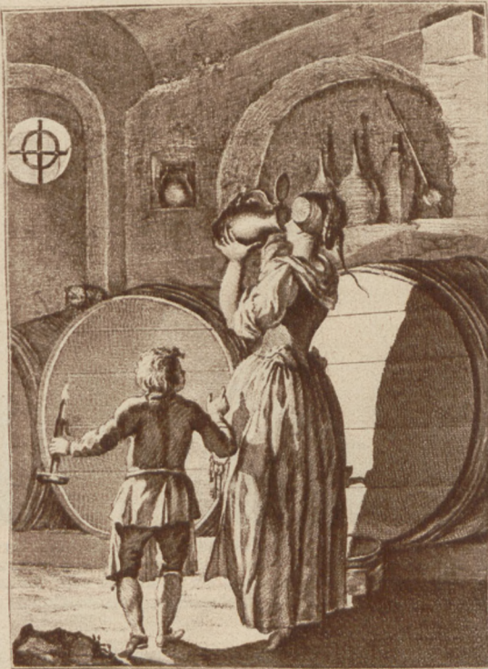
Der Keller. Im Keller fenn in einem Hauf gegraben Du haltst dich auch fein frisch das Bier so wohl als Wein. Sind also es ist doch gut so ein Credenzier haben Es wird der kalte Crinckel dir ja nicht schädlich sein.
