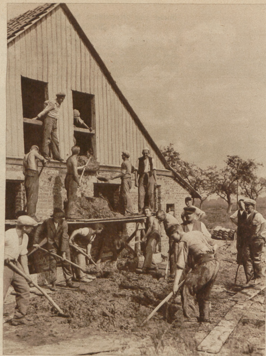
Verputzkolonne bei der Arbeit
