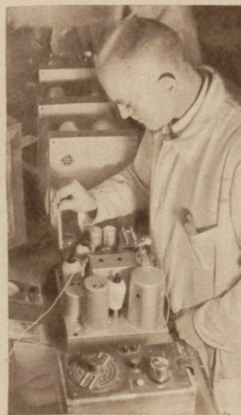
Zwischenfrequenz-Kontrolle mit einem Präzisions-Meßinstrument
