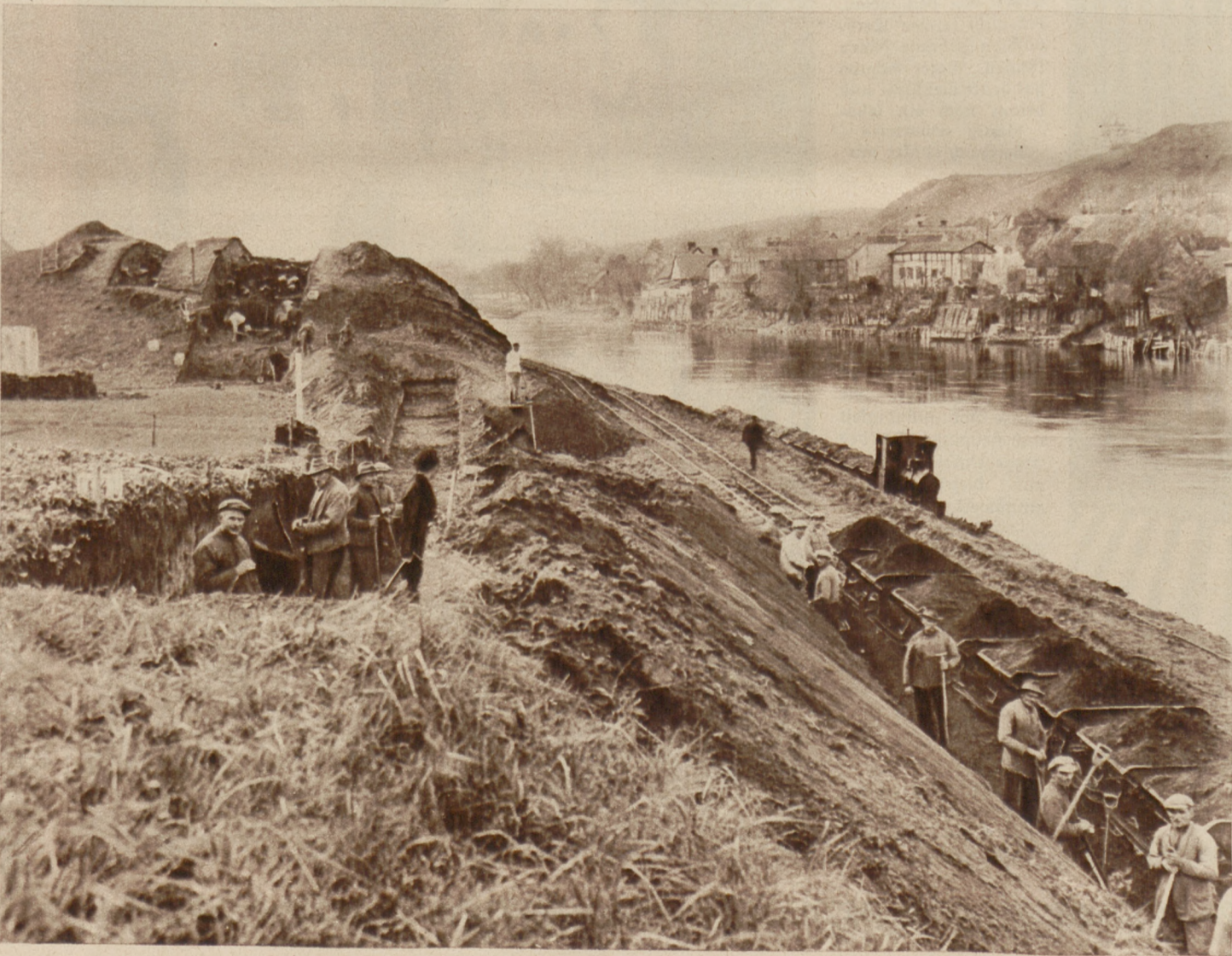
Beginn der Grabungsarbeiten. Die Grasnarbe wird abgestochen und ausgehoben. Da diese sehr fest ist, zieht ein zweiter Arbeiter mit Hilfe eines Drahtseiles den Spaten aus der Erde
