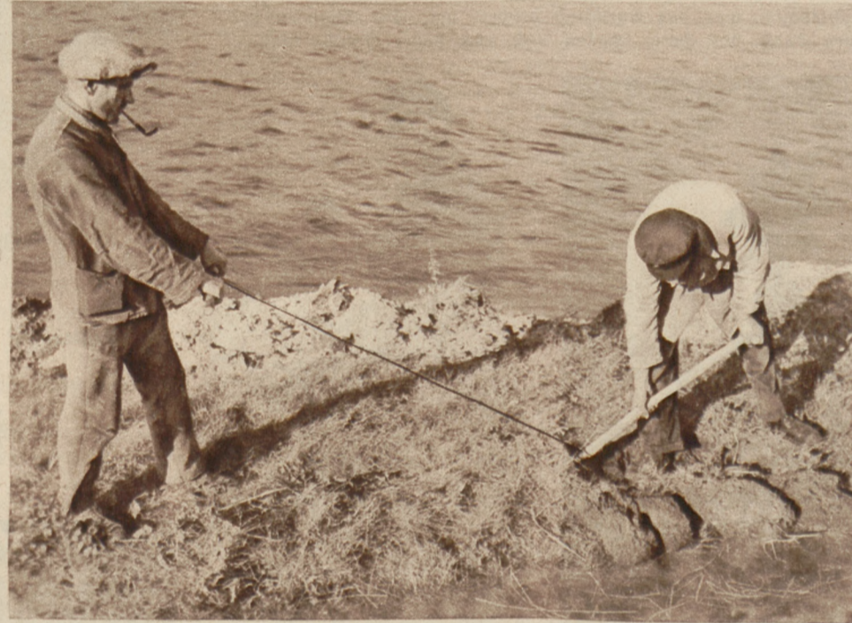
Beginn der Grabungsarbeiten. Die Grasnarbe wird abgestochen und ausgehoben. Da diese sehr fest ist, zieht ein zweiter Arbeiter mit Hilfe eines Drahtseiles den Spaten aus der Erde
