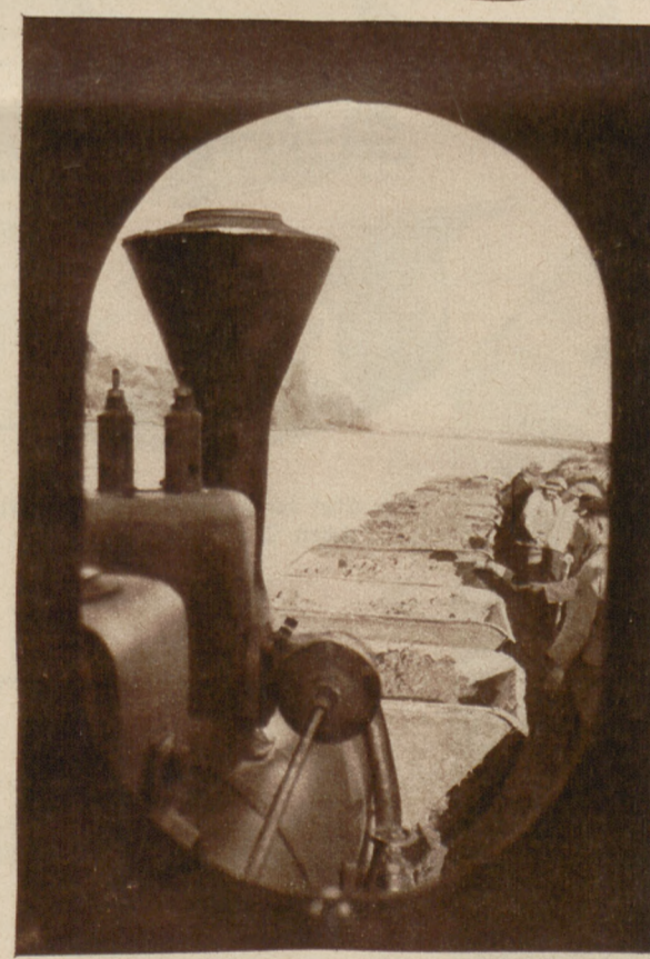
Auf vielen Gleisen und mehreren Kleinbahnzügen wird die gewonnene Erde abtransportiert. Im ganzen werden über 33000 Kubikmeter Erde bewegt. Blick durch ein Fenster der Kleinbahnlokomotive auf die mit Erde beladenen Loren
