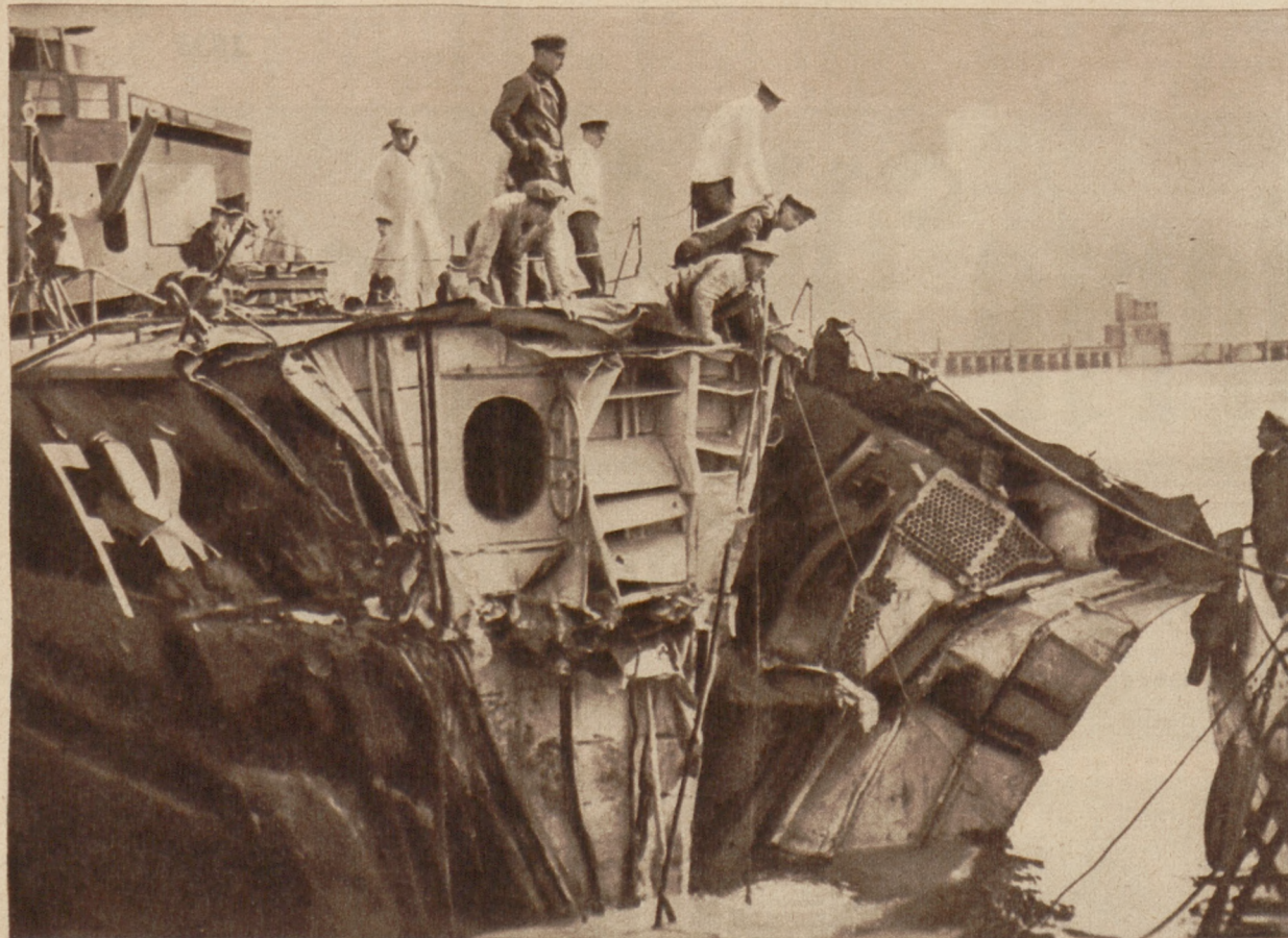
Zwerner Zusammenstoß in der Elbmündung. An der Elbmündung stießen bei dem Eisenerischiff III die beiden Torpedoboote „Halle“ und „Gondor“ aufeinander. Hierbei wurde dem Torpedoboot „Halle“ die ganze Spitze abgerissen. Das Boot mußte mit Schlepverbilfen in den Hafen von Cuxhaven geschleppt werden. — Das beschädigte Boot, dem die ganze Spitze auf über fünf Meter abgerissen wurde
