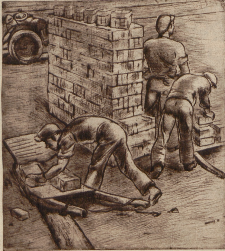
Arbeiter am Bau
