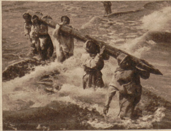
Ein schwerer Brückenpfeiler muß durch die Brandung geschleppt werden
