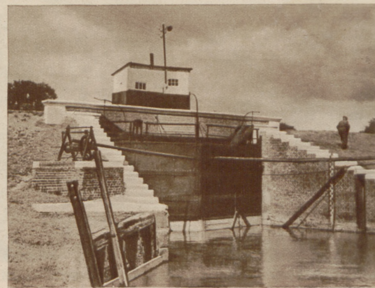
Pinks: „Siele“ nennt man eine selbsttätig arbeitende Schleusen-anlage, die die Ebbe- und Flutströmungen reguliert. Sie ist das Sicherheitsventil, das die unter dem Meerespiegel liegenden Ortschaften vor Übersutungen bewahrt. — Ansicht von der Seefleite
